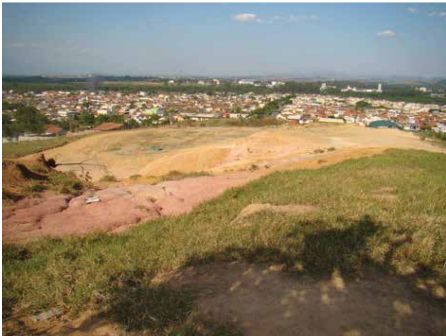
área onde será instalado o Bosque Laudato Si
